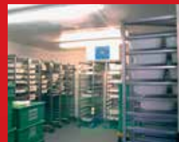
Fjärrstyrning av kylrum och närbutiker
