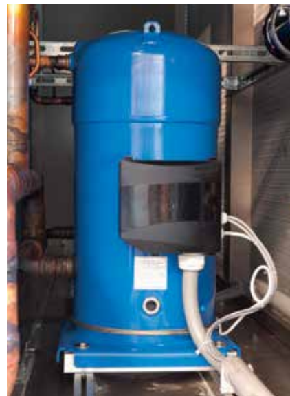
涡旋压缩机适用于草料除湿。
