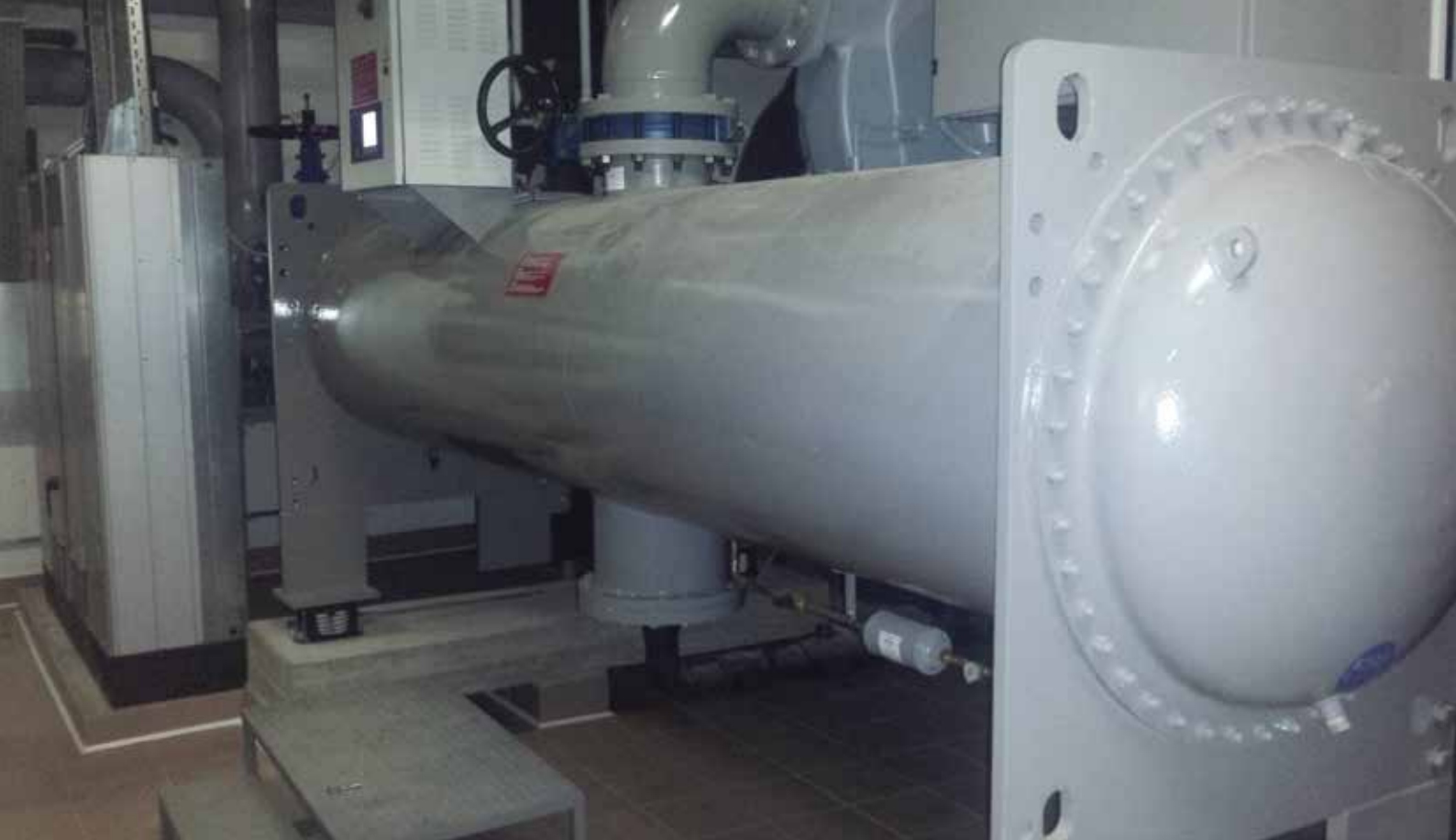
Twee 19 XR compressoren met een koelvermogen van 2245 kW en een elektrisch vermogen van 375 kW ondersteunen nu het koelsysteem.
