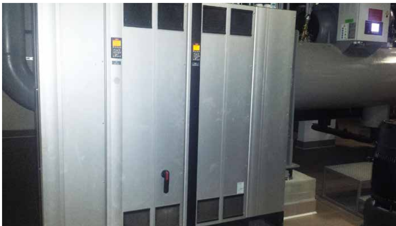
Deze VLT® Low Harmonic Drives regelen de nieuwe compressoren in de technische ruimte.
