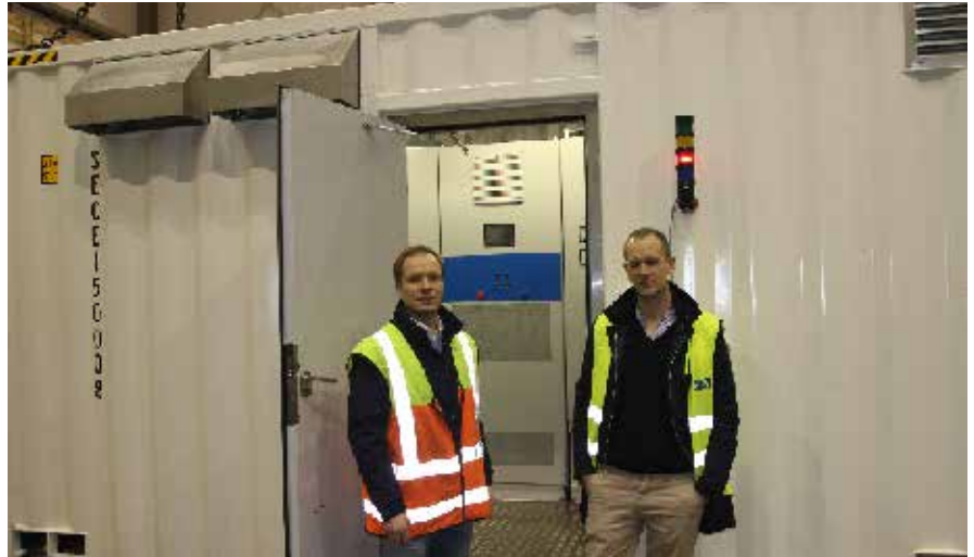
Frekvensomformer.no公司Sverre Knapstad和SEC公司Eirik Sørensen解释说: “定制的20英尺机箱内包括控制系统、VACON® NXP驱动系统、正弦波滤波器、变压器和冷却系统等全套设备。机箱非常经久耐用, 经过高质量的表面处理, 可确保在严酷环境下长期使用”。
