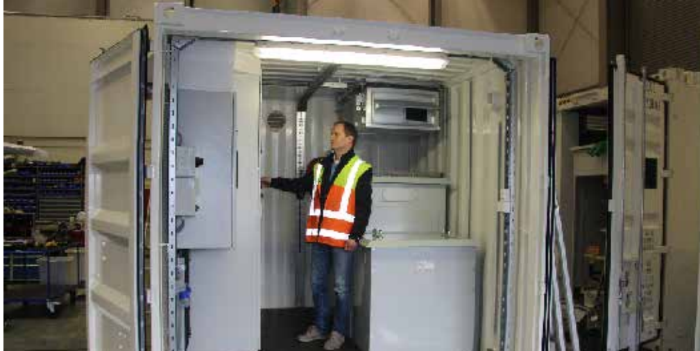
Sverre Knapstad与一台配备10-英尺机箱的崭新450 kVA紧凑型岸基供电装置。VACON®变频器安装了客户需要的控制器和指示灯。
