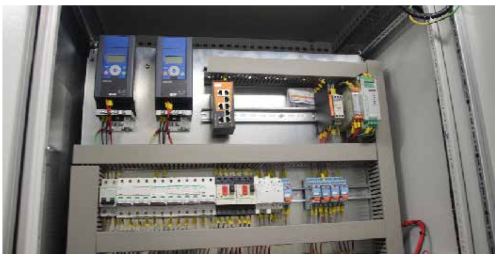
接线区操作极为便利。机箱通风扇也由VACON®变频器驱动。
