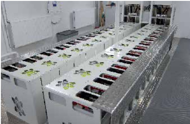
带电池管理系统的2 x 68 kWh Li-Ion EST-Floatech电池系统。
