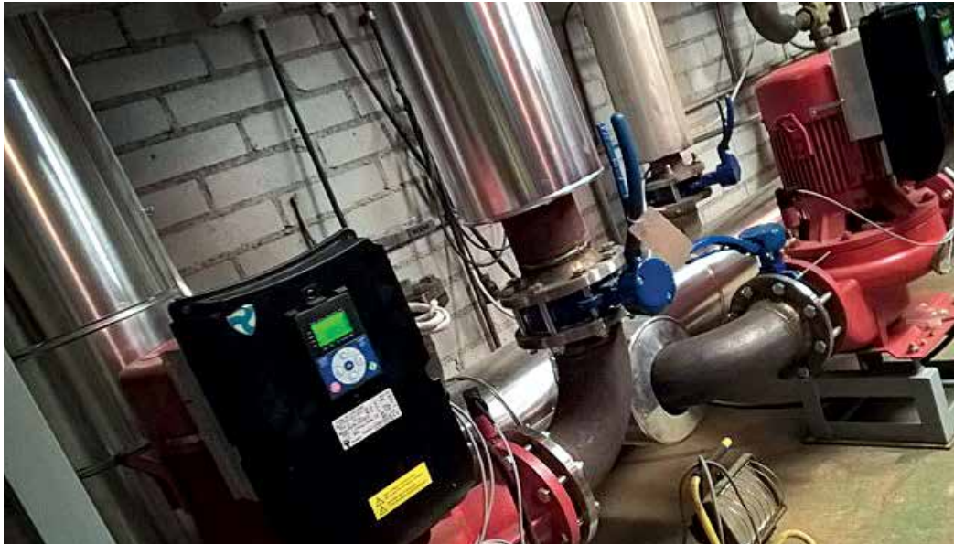
Le VACON® 20 Cold Plate est intégré dans la gamme de pompes en ligne mise à jour par Kolmeks, avec un moteur (triphase) de 7,5 kW.
