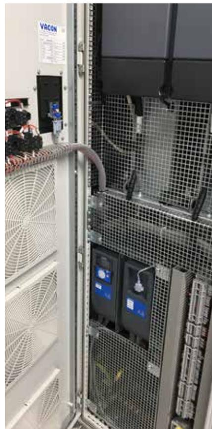
Particolare del quadro VFD che ospita un inverter della famiglia Danfoss Drives VACON® NXP
