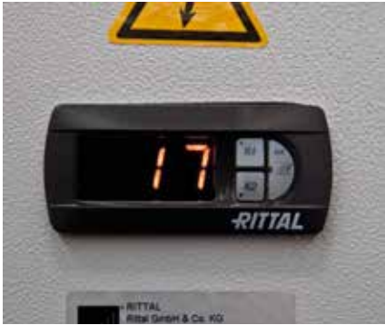
Die in der Tür integrierte Temperaturanzeige erleichtert die Überwachung und Kontrolle des Rittal LCP Industry
