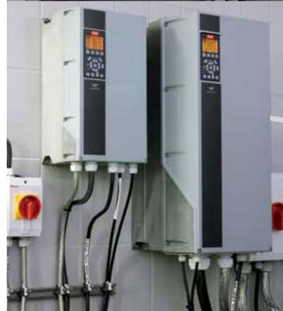
*I convertitori di frequenza sono installabili centralmente (in un armadio) o localmente (accanto al motore). Entrambe le opzioni presentano vantaggi e svantaggi.*
