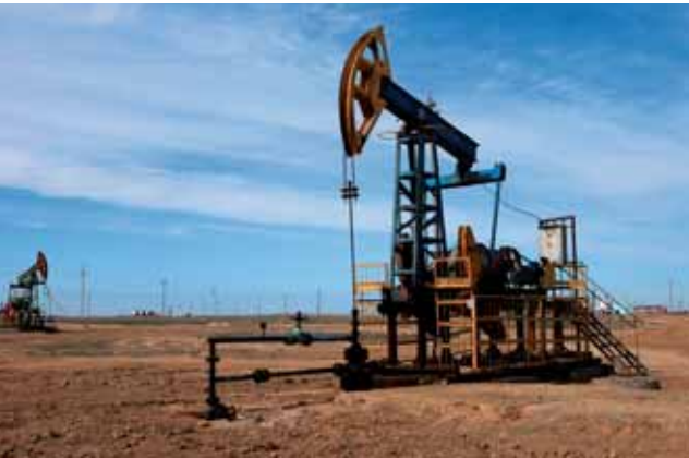
分布式泵油站安装的 >300 VLT® 高级谐波滤波器。可确保一天 24 小时进行泵油。
