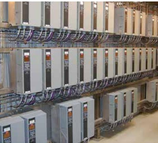
*Una instalación típica, con múltiples convertidores de frecuencia, todos ellos instalados bajo una misma fuente de alimentación, requiere a menudo una mitigación de armónicos suplementaria para evitar la distorsión de la forma de onda de tensión.*
