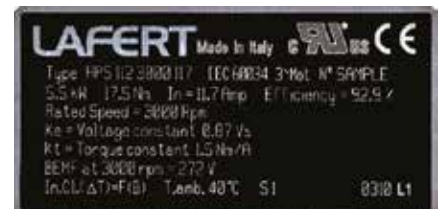
A motor adattábláján és a műszaki adatlapján lévő adatokat meg kell adni a frekvenciaváltónak.
