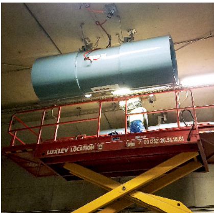
Rad na jedinici za ventilaciju.
