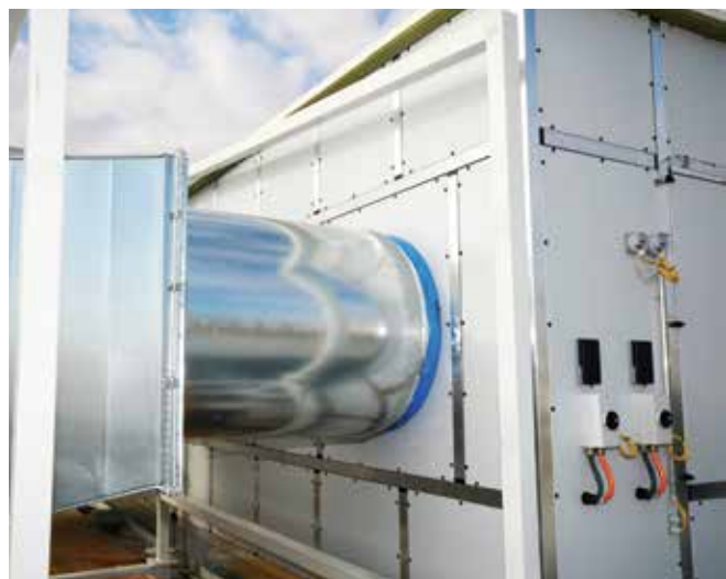
风机出口和管道系统之间的连接
