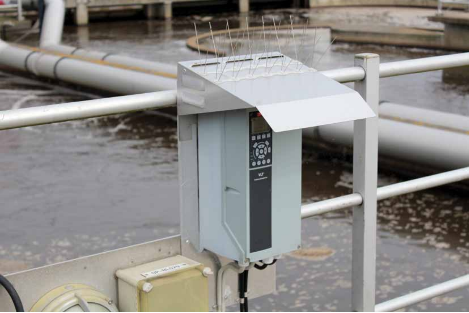
Aktif çamur nitrifikasyonu ve denitrifikasyonu: PROFIBUS ile iletişim kuran, RFI filtreli, IP 66 muhafaza sınıfına ve iklim korumasına sahip nominal 4 kW 16 adet VLT® sürücü, havalandırma mikserlerini kontrol ediyor.
