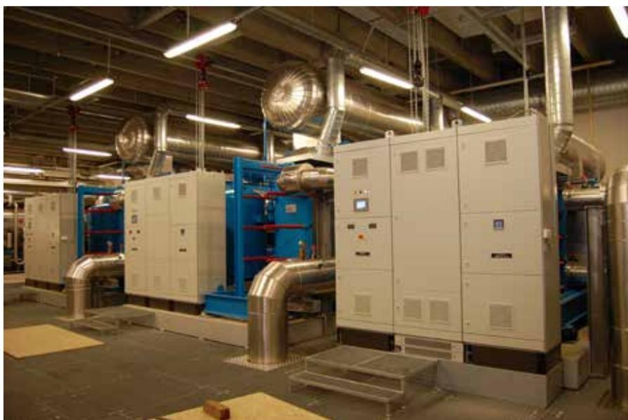
Le système de réfrigération se compose de deux compresseurs à vis de 3,5 MW et d'un compresseur à piston de 1,3 MW.
