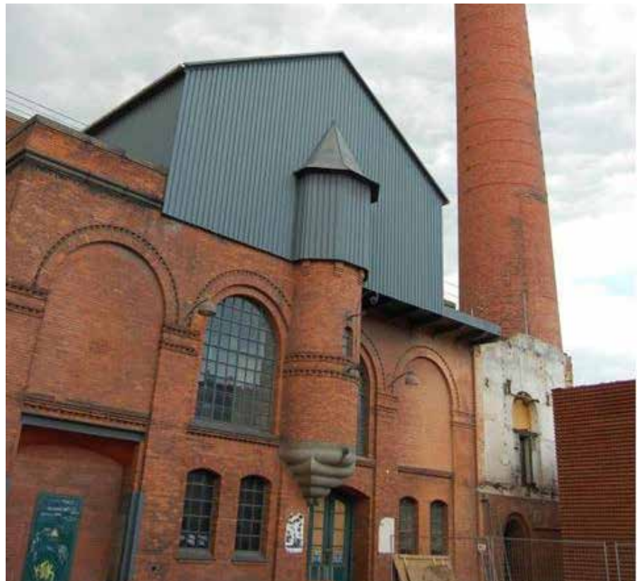
Een voormalige elektriciteitscentrale in de buurt van het plein Kongens Nytorv in het centrum van Kopenhagen heeft een tweede leven gekregen. Van hieruit voorziet de eerste grootschalige stadskoelingsinstallatie van Denemarken grote bedrijfsgebouwen zoals banken, hotels, kantoorgebouwen en vele andere bedrijven van kosteneffectieve en milieuvriendelijke koeling.
