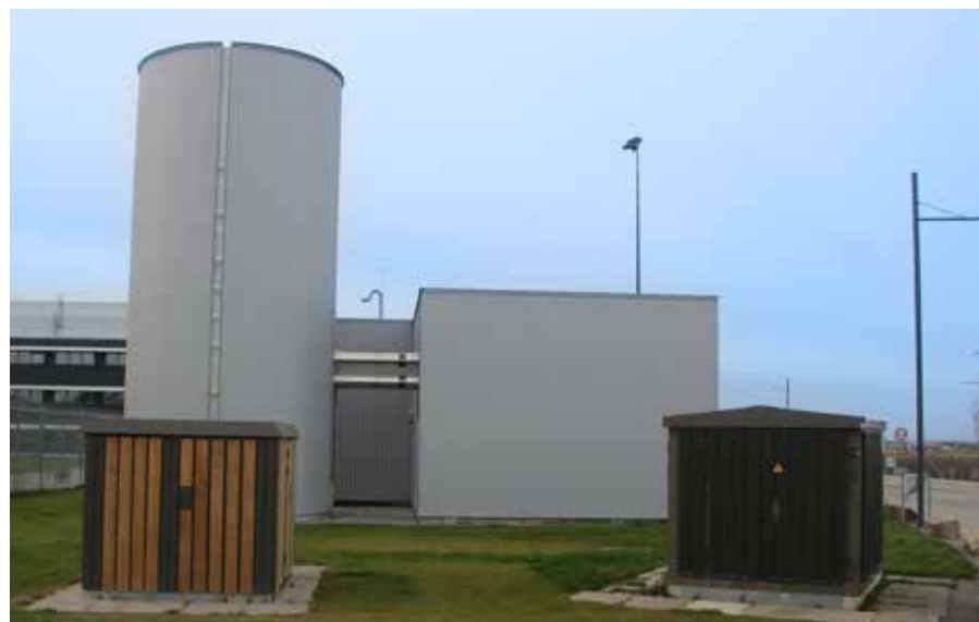
FlexHeat-anläggningen lagrar värmeenergi som motsvarar ett virtuellt batteri på 4 MWh i lagringstanken på 100 kubikmeter till vänster i bild.
