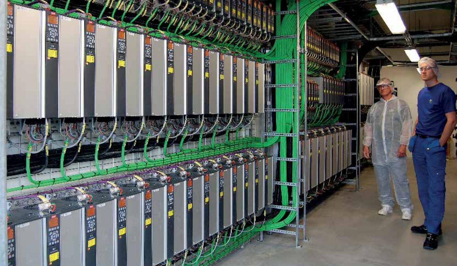
1400个 VLT® 变频器安装在一系列通风良好的控制室内，无需控制柜。
