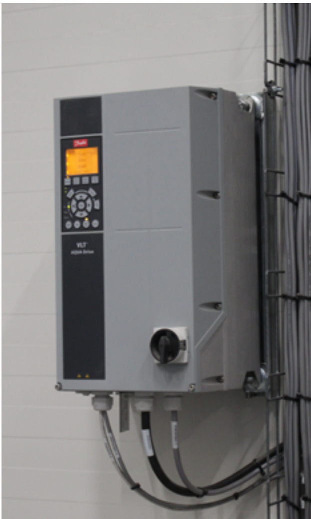
VLT® AQUA Drive FC 202 styrer pumper og blæsere på det store biogasanlæg.
