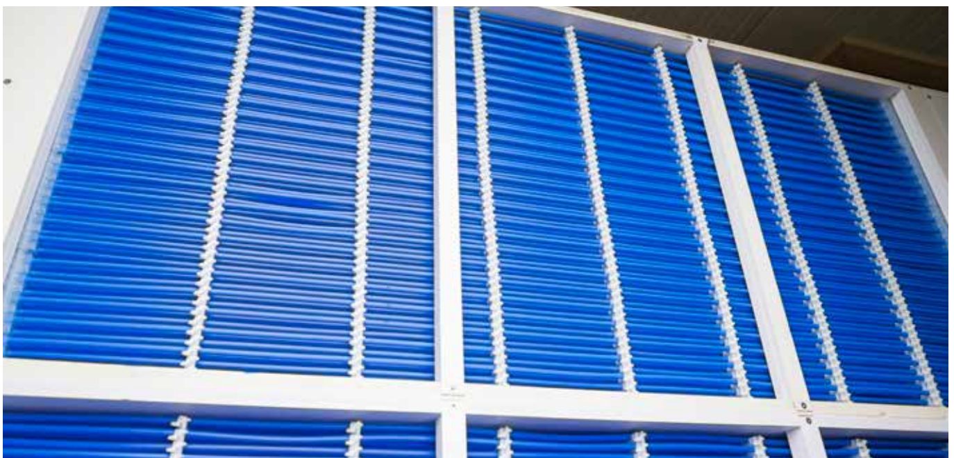
▲ Corrosievrije warmtewisselaars van Exegy die door Inno+ worden geïnstalleerd als onderdeel van het geavanceerde klimaat- en warmteterugwinningssysteem.
