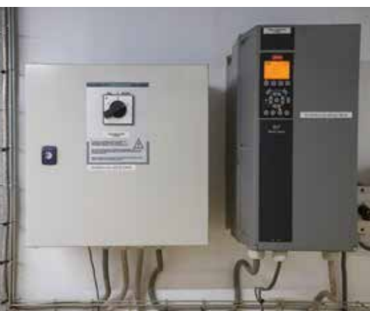
▲ Een robuuste VLT® frequentieregelaar met IP55 bescherming regelt de klimaatbeheersingsapparatuur van Stienen.
