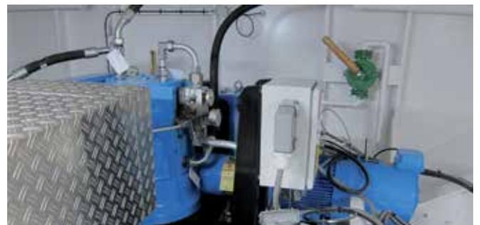
Chaque salle des machines comporte deux générateurs John Deere/Stamford de 133 kW, soit quatre générateurs au total. Chacune se trouve à une extrémité du navire. Le filtre du gaz d'échappement Solfic SCR élimine les gaz et particules toxiques.
