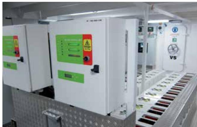
Les deux systèmes de batterie EST-Floattech ion-lithium 68 kWh avec système de gestion de batterie.
