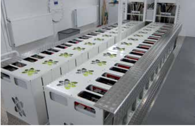
Akü yönetim sistemine sahip 2 adet 68 kWh Lityum İyon EST-Floattech Akü sistemi mevcut.
