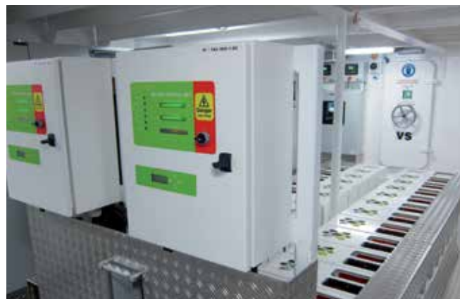
Dwa układy akumulatorów litowo-jonowych 68 kWh EST-Floattech z systemem zarządzania akumulatorami.
