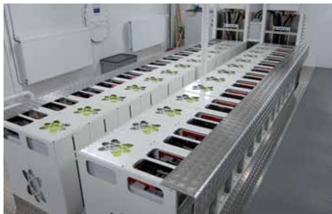
Dwa układy akumulatorów litowo-jonowych 68 kWh EST-Floattech z systemem zarządzania akumulatorami.
