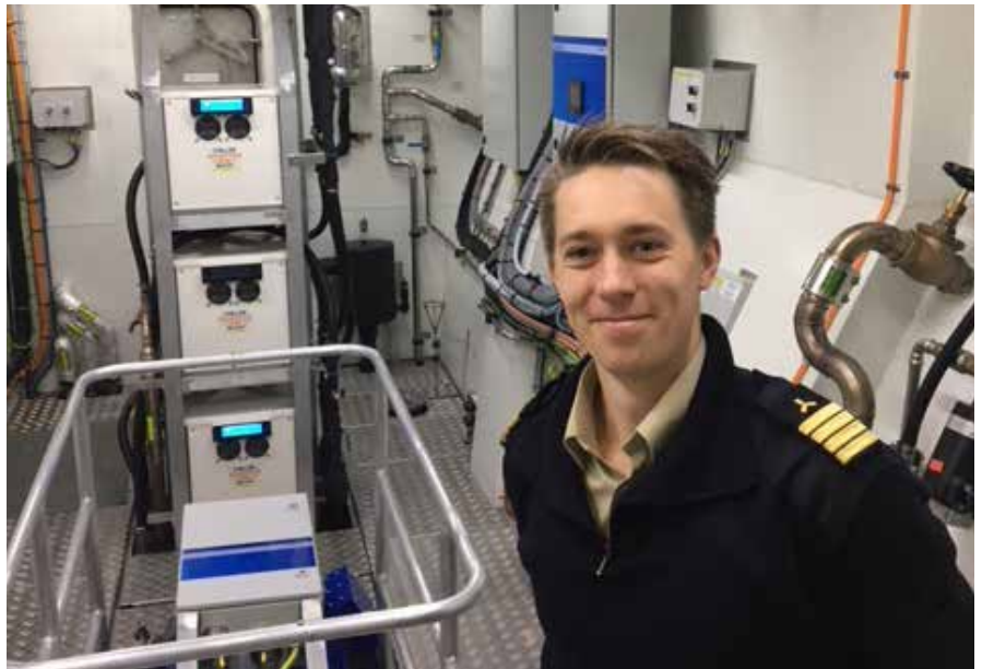
Lars Haugnes is bijzonder tevreden over de prestaties van de Danfoss frequentieregelaars en instrumentatie die in de machinekamer van Future of the Fjords zijn geïnstalleerd en in hoge mate bijdragen aan het beschermen van de ongerepte omgeving van de fjord.
