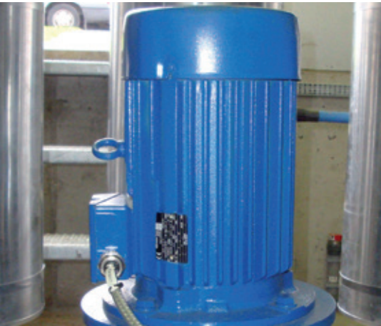
Trium pumpen er forsynet med en VEM permanentmagnetmotor og VLT® frekvensomformer - som er medvirkende til at opnå en god systemvirkningsgrad.
