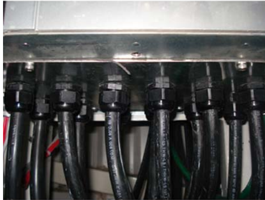
Illustration 3.14: Exemple d'installation correcte de la plaque presse-étoupe.
