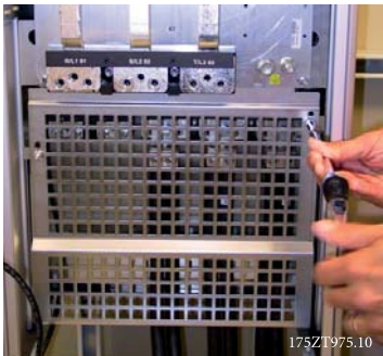
Kuva 4.8: EMC-standardin mukaisen suojuksen asentaminen.
