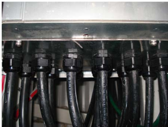
Illustration 3.25: Eksempel på korrekt installation af tætningspladen.
