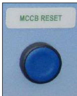
Rysunek 30. Przycisk kasowania wyłącznika MCCB RESET (-S11)
