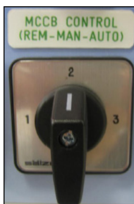
Rysunek 25. Przełącznik wyboru rodzaju sterowania ładowaniem i MCCB (-S6)
