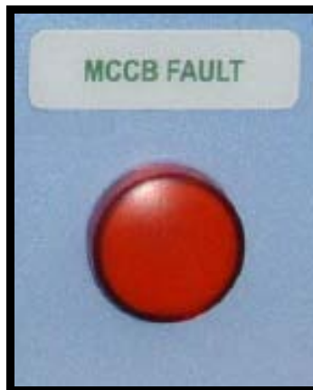
Abbildung 7 29. Anzeigelampe „MCCB FAULT“
