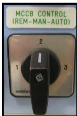
Figura 7-1 Conmutador de selección del control de MCCB (-S6)
