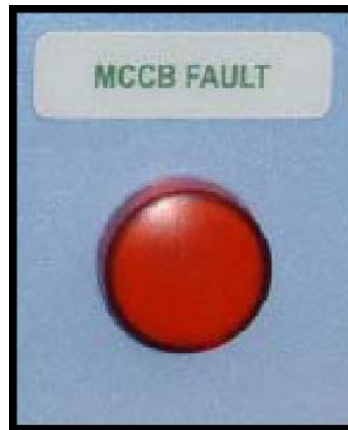
Figura 7-5 Indicador de FALLO MCCB
