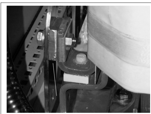
Figura 5-6. Toma de las reactancias de entrada en convertidores FR13/FR14
