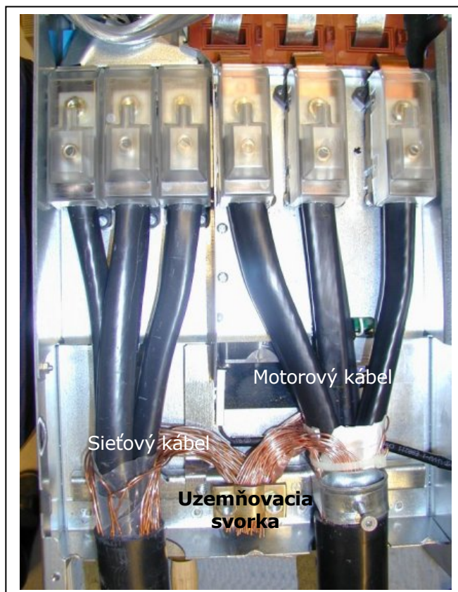
Obr. 6-16. Inštalácia káblov Vacon NX, FR8
