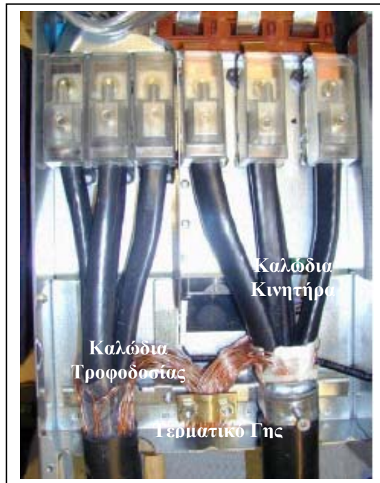
Σχήμα 6-15: Τοποθέτηση καλωδίων στο Vacon NX FR8.
