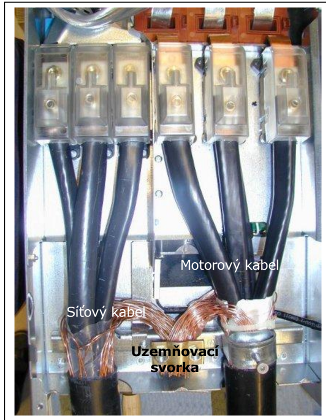
Obr. 6-17. Instalace kabelů Vacon NXS/P, FR8
