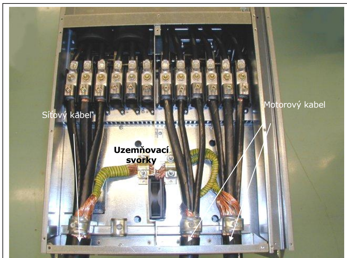
Obr. 6-20. Instalace kabelů Vacon NXS/P, FR9
