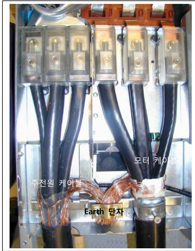
그림 6-18. Vacon NXS/P, FR8의 케이블 설치
