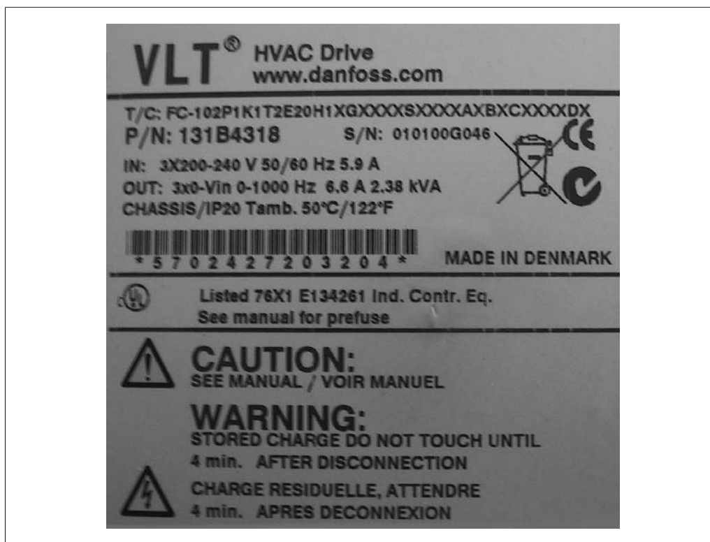
Illustration 2.1: Dieses Beispiel zeigt ein Kennschild.
