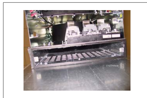
Illustration 3.33: Nederste kabeladapter installeret
