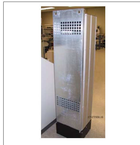
Illustration 3.30: Åbninger bagpå bruges ikke i denne applikation
