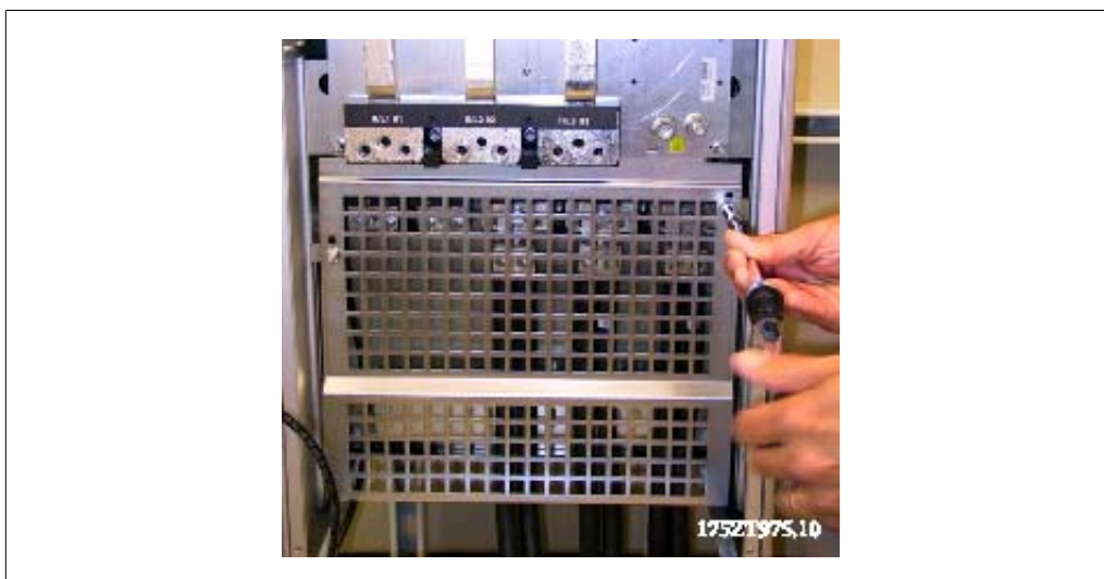
Illustration 3.81: Montering af EMC-skærmen.
