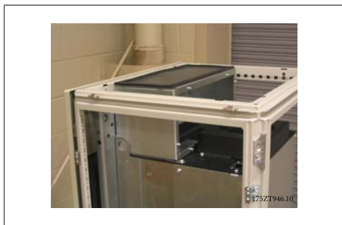
Disegno 3.46: Condotta superiore installata
