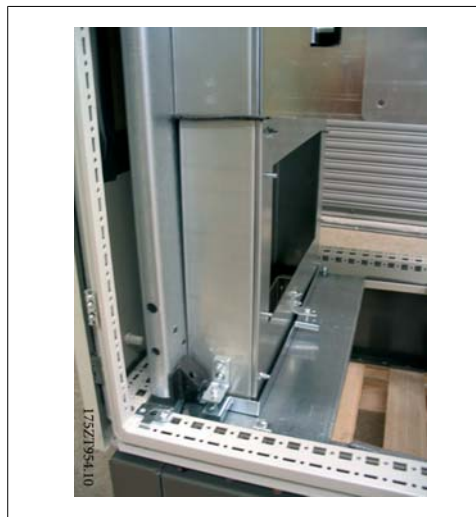
Disegno 3.54: Montare temporaneamente il gruppo condotto per contrassegnare l'apertura sulla piastra passacavi
