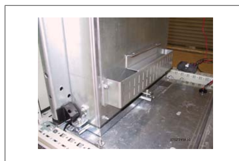
Disegno 3.59: Condotto inferiore installato.
