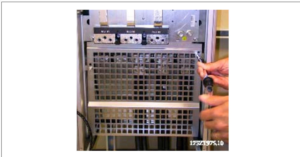
Disegno 3.81: Montaggio della schermatura EMC.
