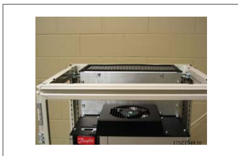
Disegno 3.48: Piastra di chiusura del condotto superiore installata
