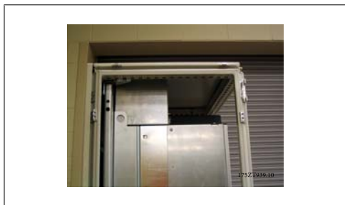
Bild 3.38: Övre kanal och kapslingstopp installerad
