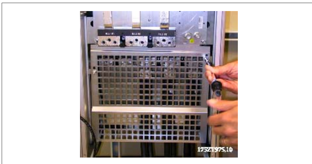
Bild 3.81: Montering av EMC-skärm
