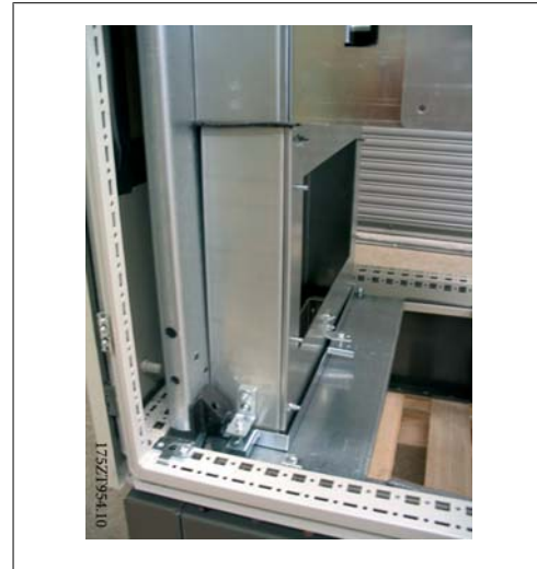
Bild 3.54: Montera tillfälligt kanalen för att märka ut utskärningen på boxen
