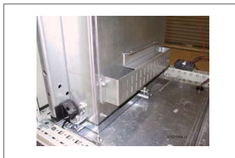
Bild 3.59: Nedre kanal monterad.
