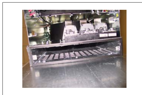
Bild 3.33: Nedre kanaladapter monterad
