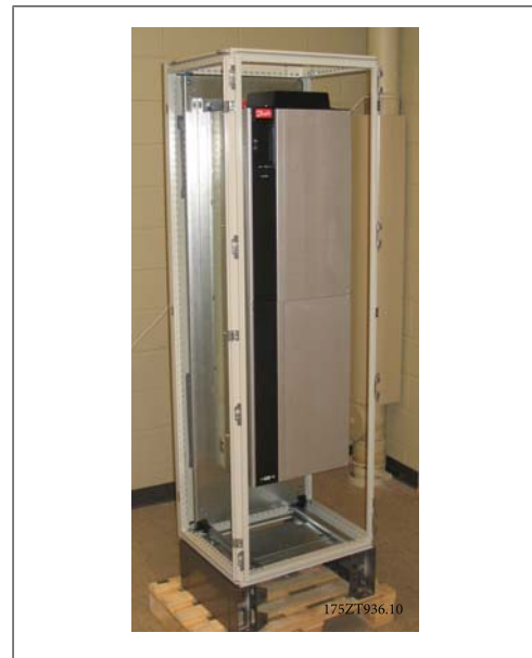
Kuva 3.36: Taajuusmuuttaja asennettuna kaappiin
