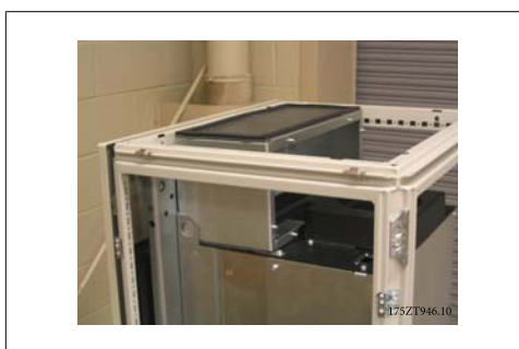
Kuva 3.46: Putkiston yläosa asennettu
