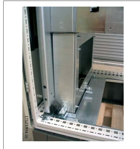
Kuva 3.54: Asenna putkisto tilapäisesti merkitäk- sesi pois leikattavan kohdan läpivientiin
