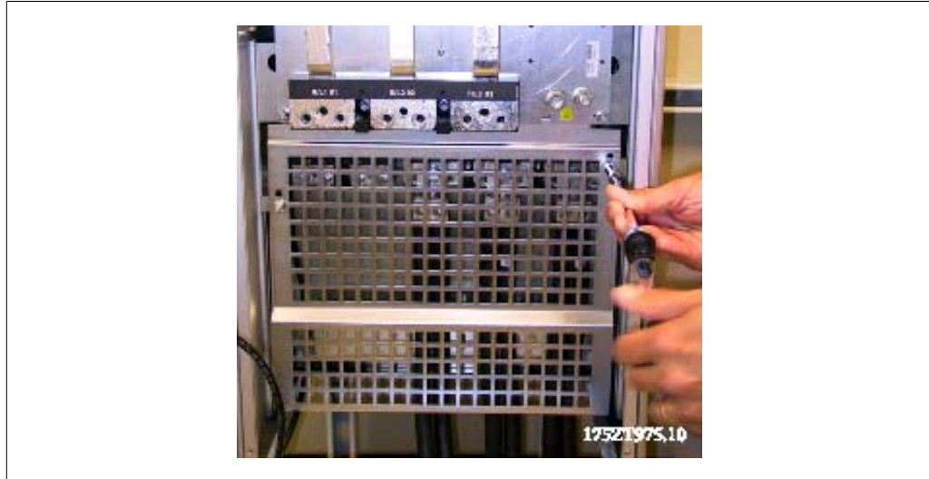
Kuva 3.81: EMC-standardin mukaisen suojuksen asentaminen.
