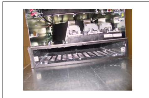
Kuva 3.33: Pohjaputken sovitin asennettuna
