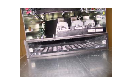
그림 3.33: 설치된 하단 덕트 어댑터
