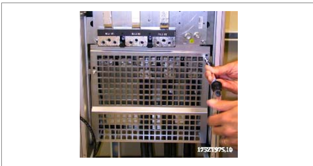
그림 3.81: EMC 차폐용 금속 덮개 장착.
