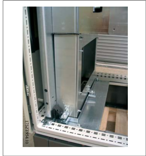
그림 3.54: 절단선을 표시하기 위해 덕트를 글랜드에 임시로 설치하십시오.
