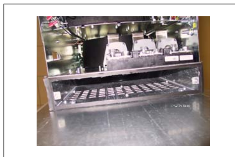
Ilustracja 3.33: Zainstalowana złączka dolnego kanału
