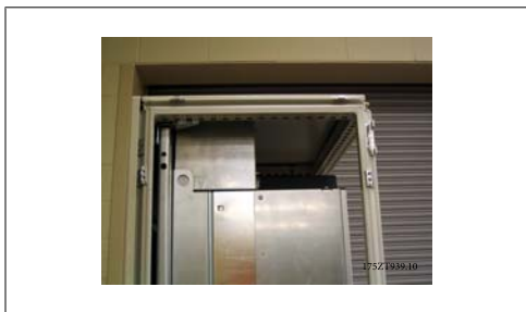
Ilustracja 3.38: Zainstalowany górny kanał oraz górna część obudowy
