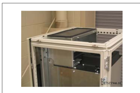
Ilustracja 3.46: Zainstalowany górny kanał
