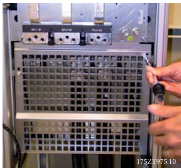
Kuva 4.15: EMC-standardin mukaisen suojuksen asentaminen.
