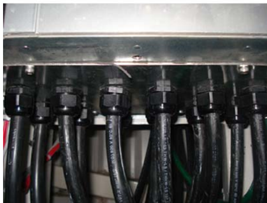
Рисунок 3.35: Пример правильной установки платы уплотнений.
