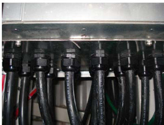
Ilustracja 4.24: Przykład poprawnej instalacji płyty dławika.
