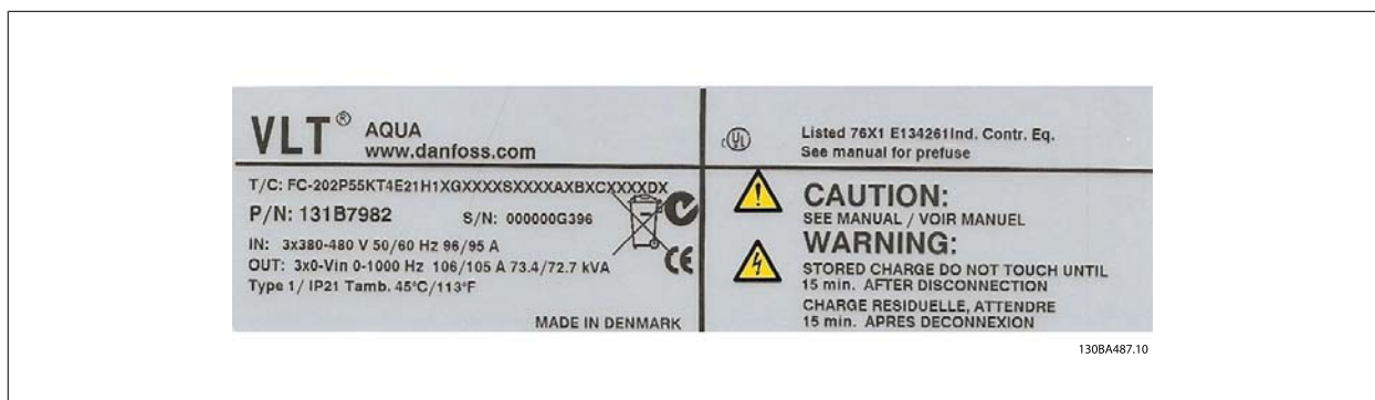
Bild 3.1: I det här exemplet visas en identifieringsmärkning frekvensomformaren VLT AQUA.
