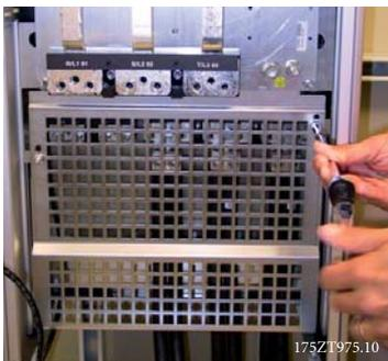
Ilustração 5.36: Montagem da proteção de EMC
