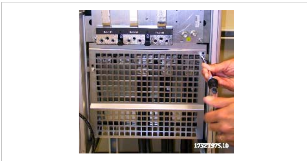
Ilustración 3.81: Instalación del apantallamiento EMC.
