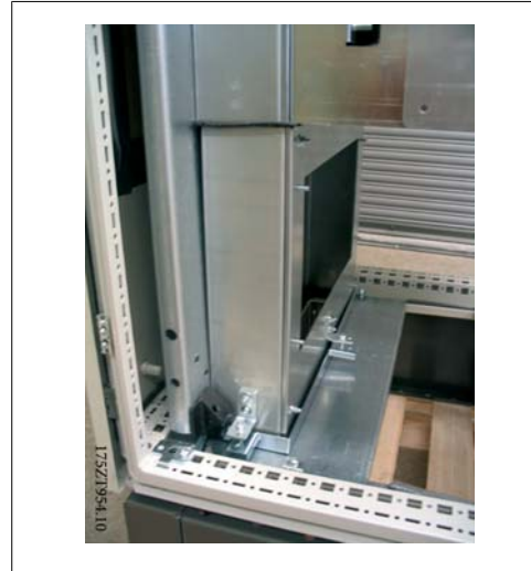
Ilustración 3.54: Instale temporalmente el sistema de ventilación para marcar la abertura en el prensacables.
