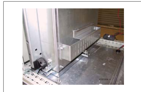
Ilustración 3.59: Conducción inferior instalada.
