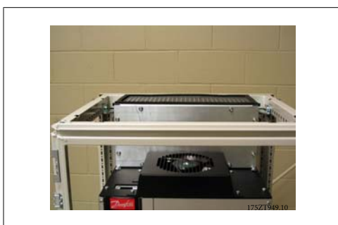
Ilustración 3.48: Placa de cierre de conducción superior instalada
