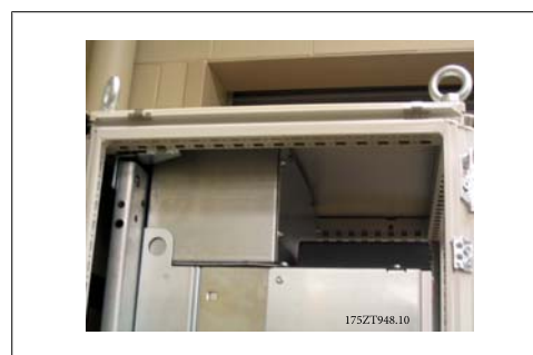
Ilustración 3.49: Parte superior del armario instalada
