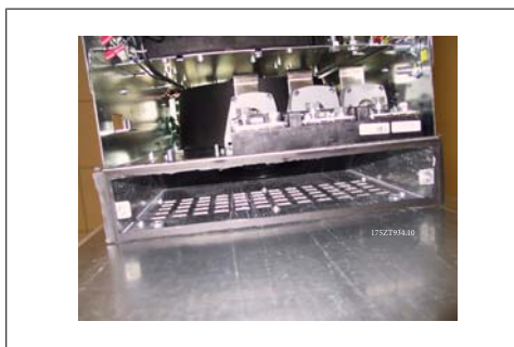
Ilustración 3.33: Adaptador de la conducción inferior instalado
