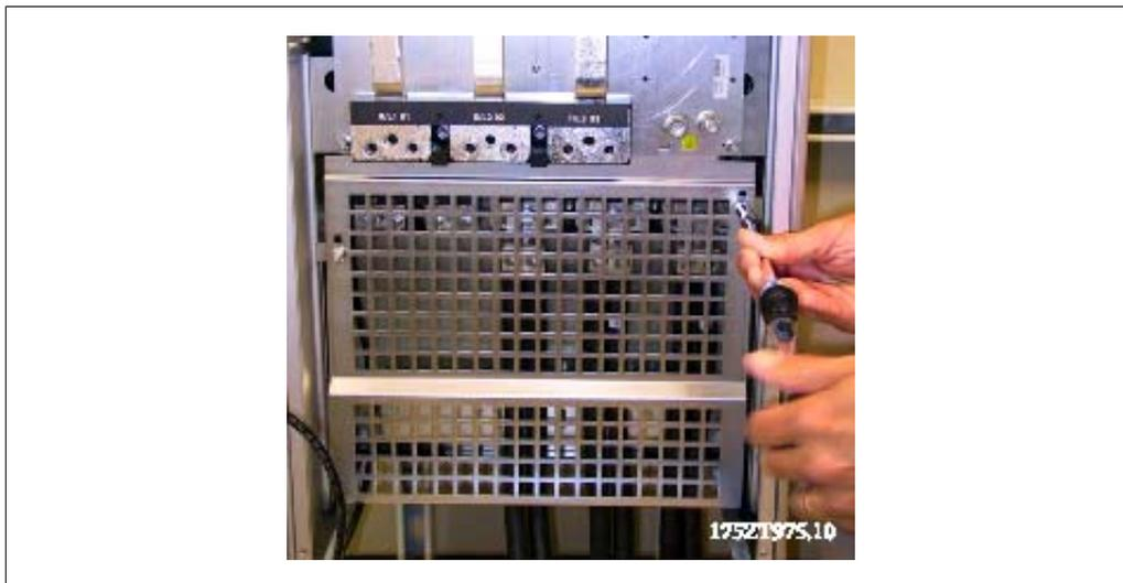
Disegno 3.81: Montaggio della schermatura EMC.
